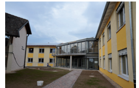
Neubau (2. Bauabschnitt) mit Gemeinschaftsräumen.
