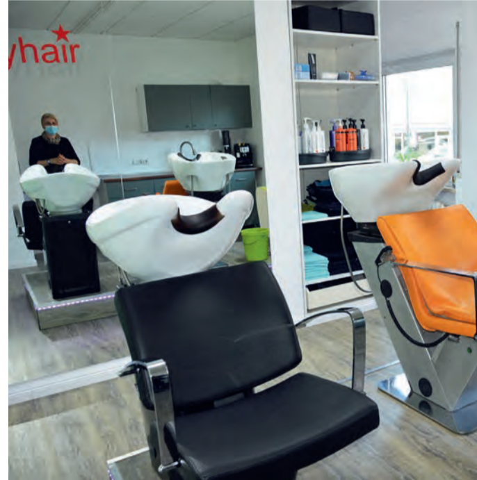
In einem Nebenraum wurden die Waschbecken für die Haarwäsche montiert. Fotos: Gerhard Lück
